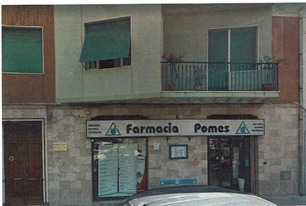
Foto n. 1 – vista locale commerciale, piazza Aldo Moro n.4/5
